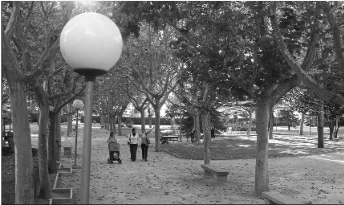
Farolas instaladas en el parque de Los Fueros, con bombillas tradicionales
